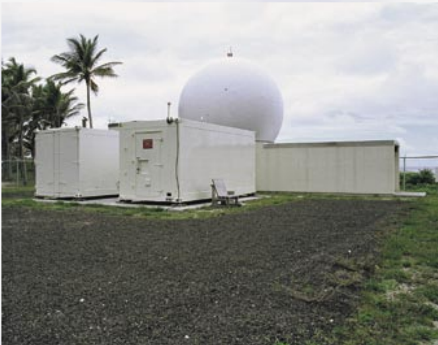
Součástí komplexního systému je i komunikační stanice pro přenos řídicích povelů.
